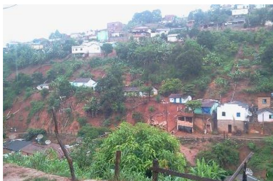
Figura 3-14 - Deslizamento no Bairro São Vicente.
