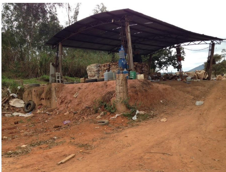
Figura 3-48 - Galpão de triagem.
