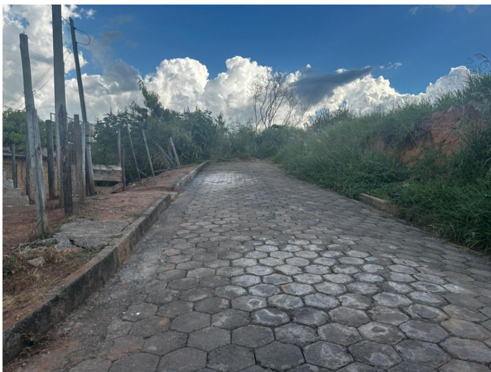
Figura 8: Fotografia da rua existente de acesso ao terreno
