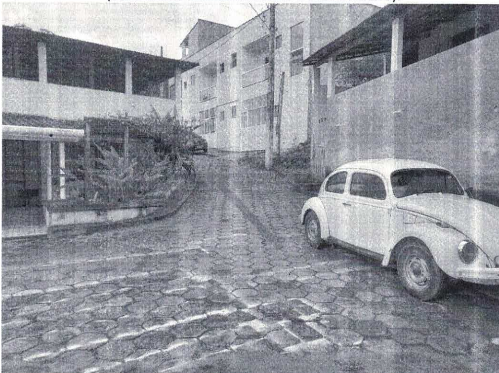
FOTO 01 – MOSTRA O INÍCIO DA RUA "0502", SAINDO DA RUA ANTÔNIO JOSÉ DA ROCHA.
