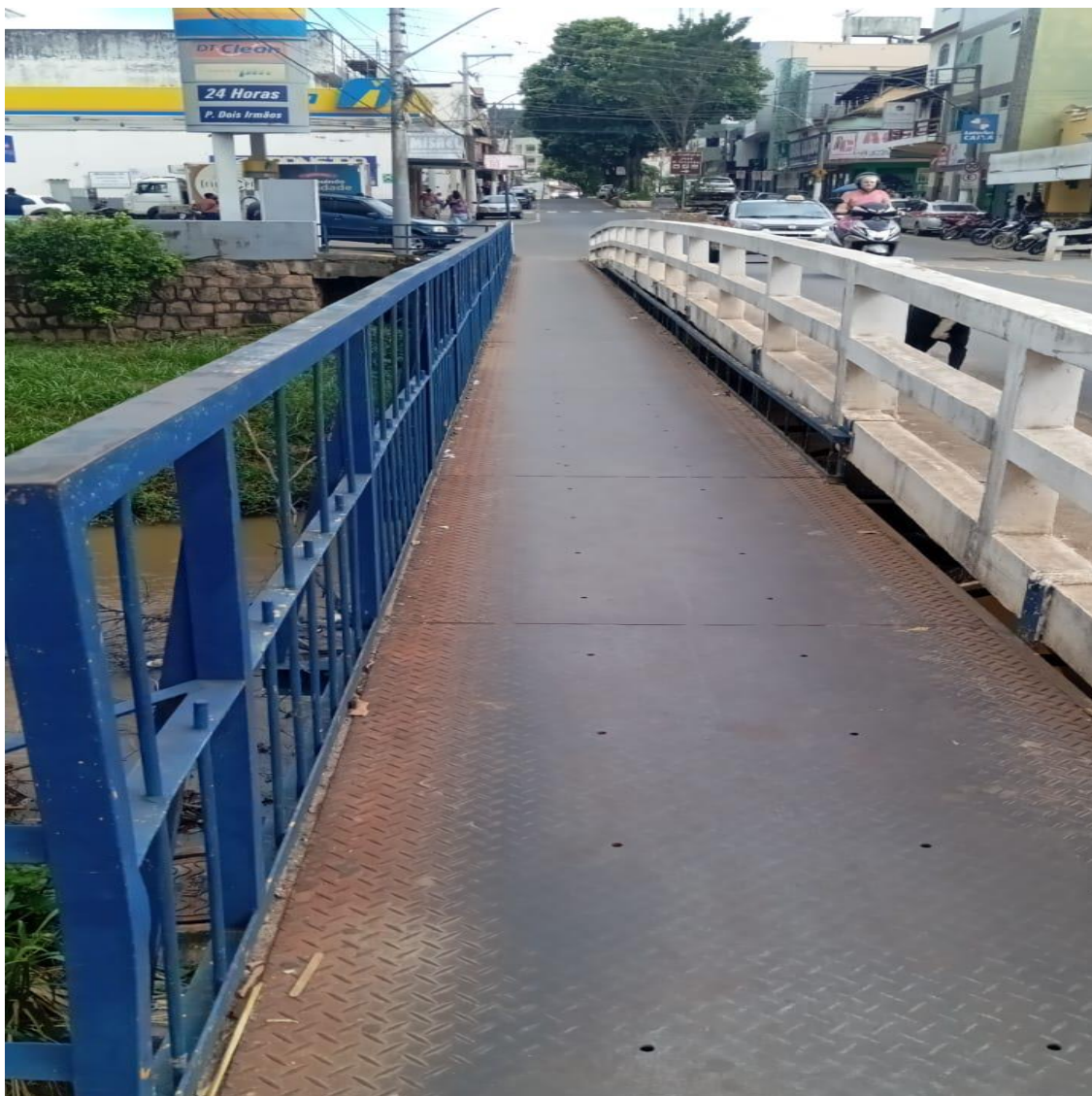
Foto da Ponte com o meio liso.
